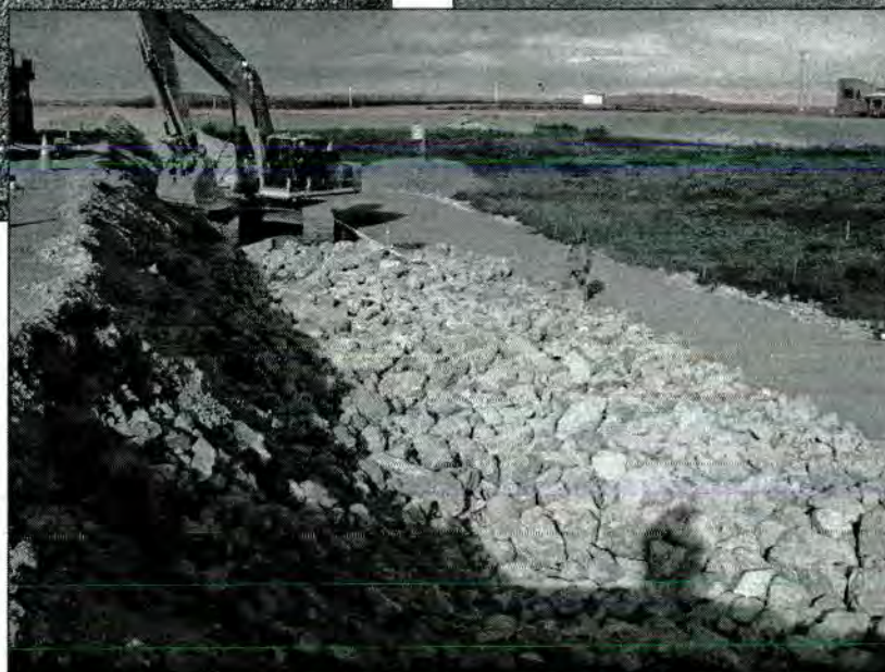
Remblai à convection - Tasiujaq
