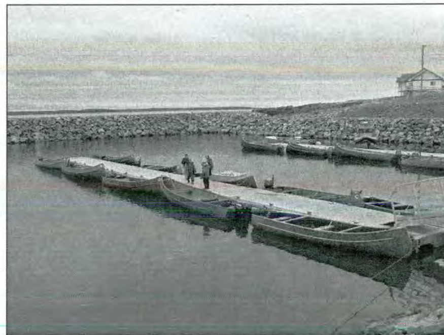
Infrastructures maritimes de Puvirnituk
