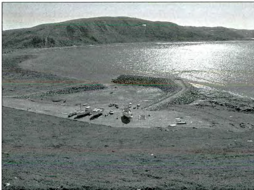
Infrastructures maritimes de Kangiqsujuaq
